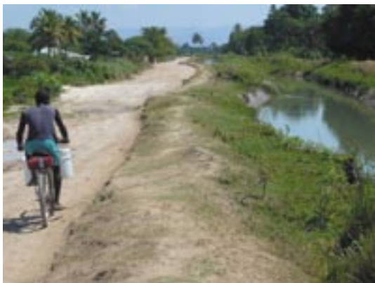
The main irrigation canal overrun by sediment and vegetation build-up. The banks are not well protected, and locals are only a few metres away / Le canal principal d'irrigation fortement sédimenté et envahi par les végétaux. Les berges sont mal protégées et les habitations sont à quelques mètres
