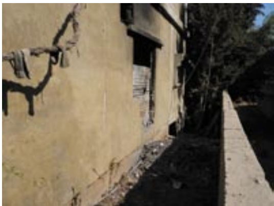
The damages sustained by Salim's house in Nahr El Bared / La maison de Salim dans le camp de Nahr El Bared avant la phase de réparation
